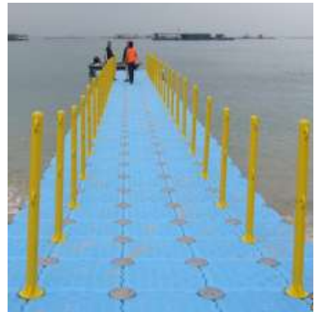
Soportes quitamiedos de HDPE colocados en el interior
