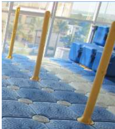
Soportes quitamiedos de HDPE colocados en el interior
